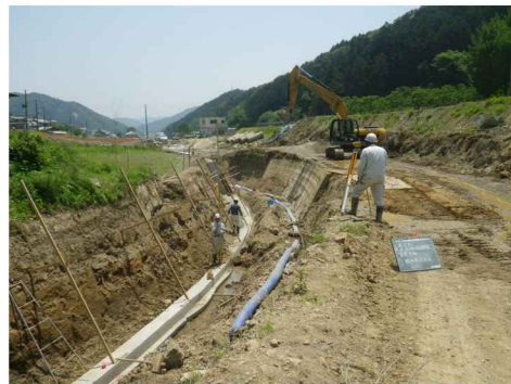
測量・丁張設置
