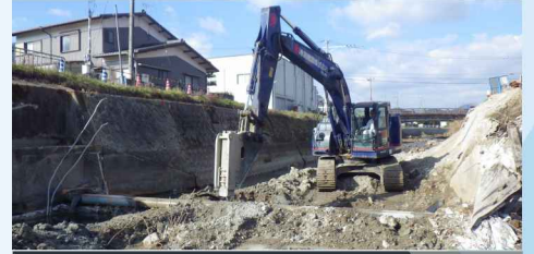
地中障害物除去
